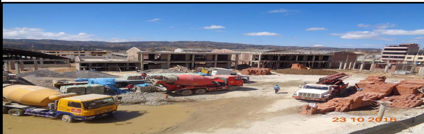
REHABILITACION Y REMODELACION DE LA INFRAESTRUCTURA EDUCATIVA Y EQUIPAMIENTO DE LA INSTITUCION EDUCATIVA NUESTRA SEÑORA DE LA ASUNCIÓN Cajamarca - Cutervo - Cutervo
