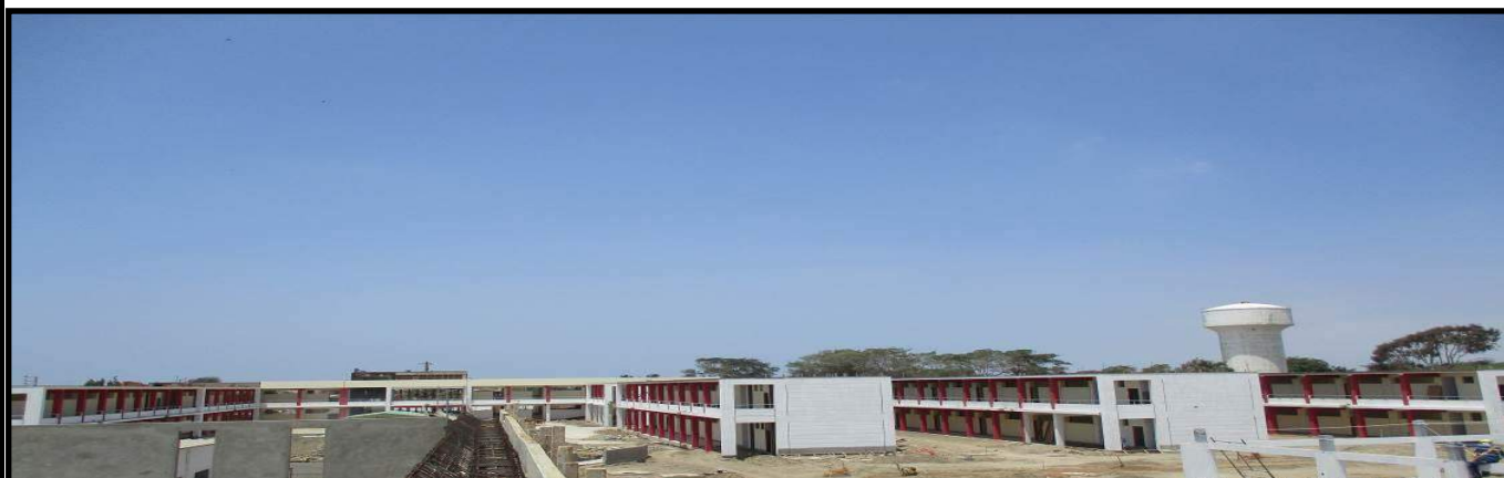
ADECUACIÓN, MEJORAMIENTO Y SUSTITUCIÓN DE LA INFRAESTRUCTURA EDUCATIVA DE LA INSTITUCIÓN EDUCATIVA "JOSÉ ANDRÉS RÁZURI" San Pedro de Lloc – Pacasmayo – La Libertad
