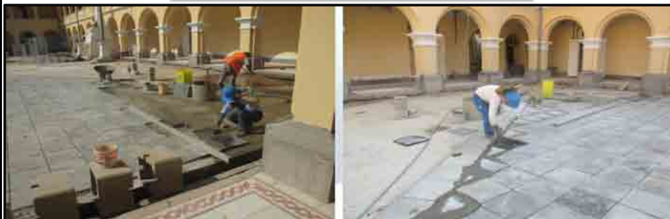
I.E. Leoncio Prado - Huánuco - Obra en Ejecución.
