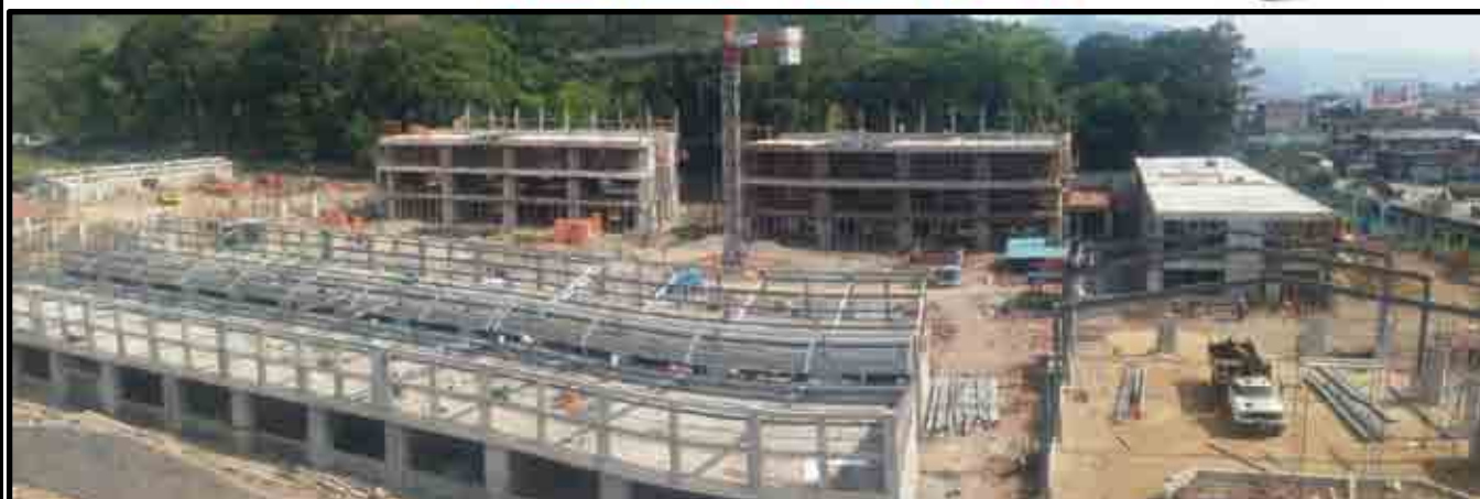
I.E. Gómez Arias Davila-Tingo María Huánuco - Obra en Ejecución
