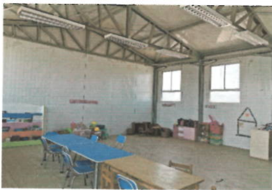
Foto N° 02: Vista interior de MPF en regular estado
