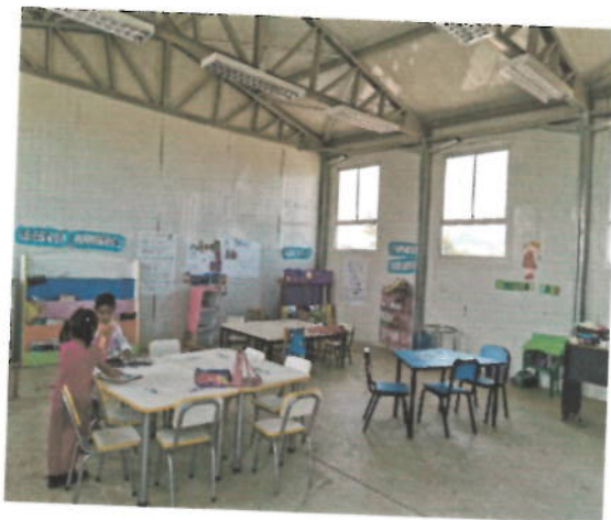
Foto N° 01: Vista interior de MPF en regular estado
