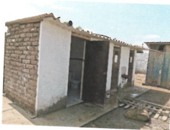
Foto N° 01: Vista general de Edificación
