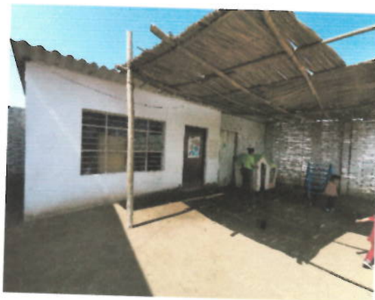
Foto N° 01: Vista frontal de edificación
