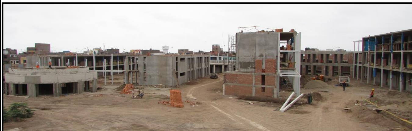
I.E. José Granda -Lima - San Martín de Porres - Obra en Ejecución
