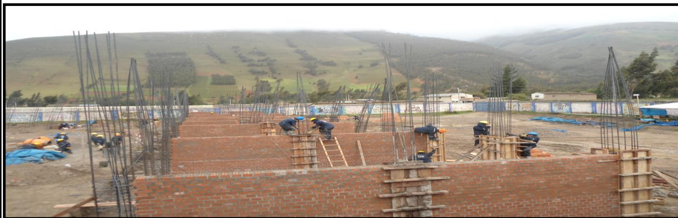
I.E. Daniel Hernández - Huancavelica - Tayacaja - Pampas Obra en Ejecución.
